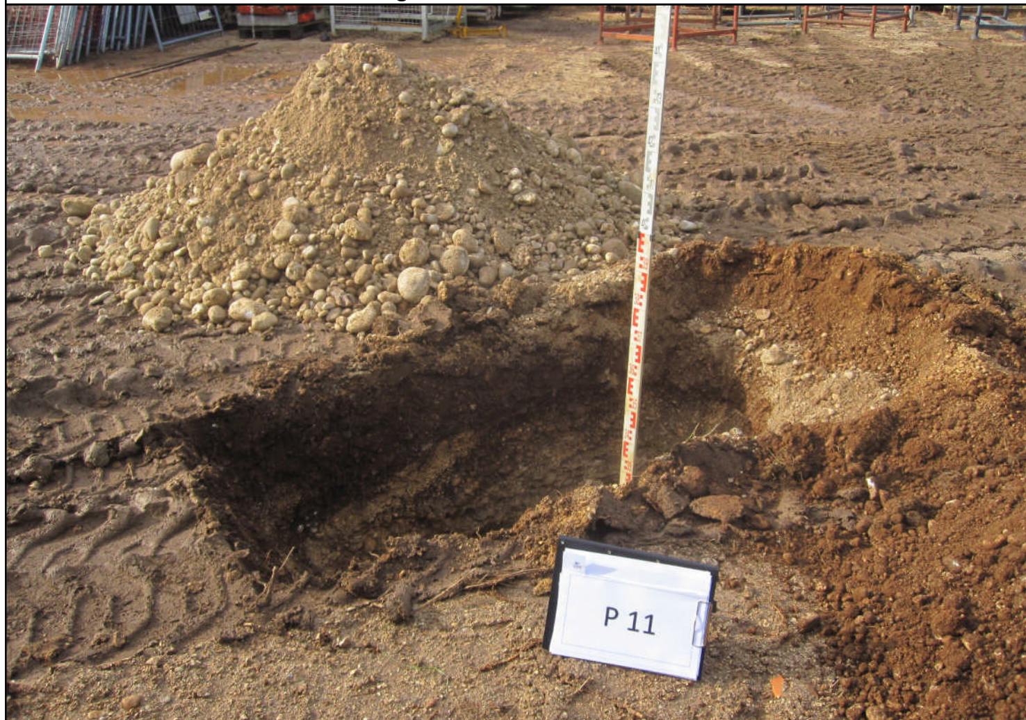
Vista d'insieme della sezione stratigrafica relativa alla trincea esplorativa n.11 e litologia rinvenuta durante lo scavo
